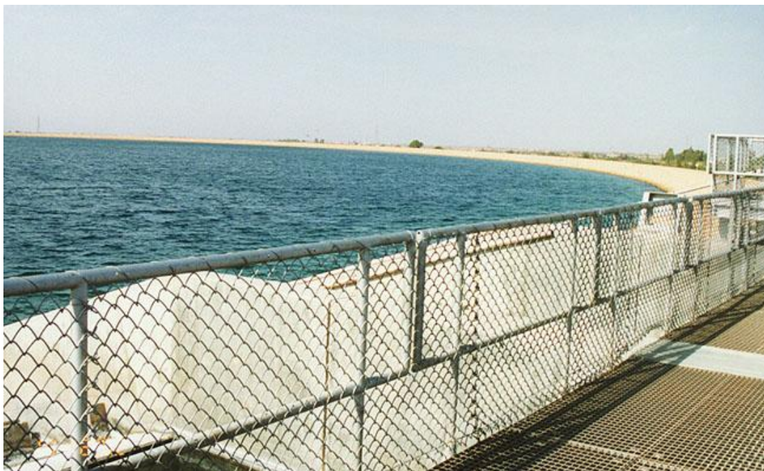
Um dos reservatórios
