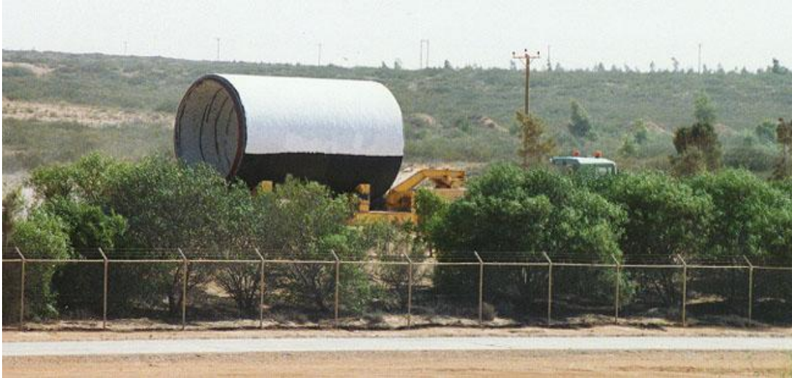
Tubulação a ser entregue
