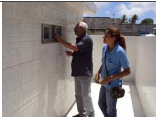
Foto 15 - Ambiente totalmente fechado azulejado com janela de observação
